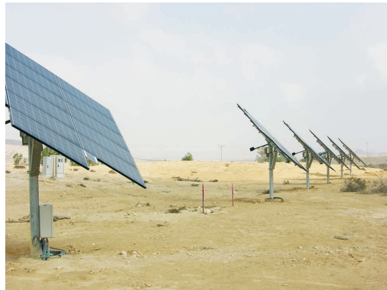
יחידות עוקבות בחוות טנא. היחידות מתחילות לנוע עם זריחה מצד מזרח ועוקבות אחרי מסלול השמש לקבלת כמות אור מרבית.
