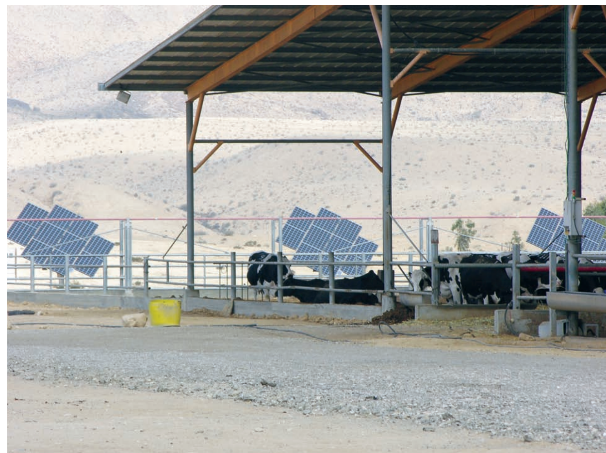
פרות יחידות עוקבות בחוות טנא. בחווה שמונה יחידות עוקבות של 2 kWp כל יחידה, ועל גג הרפת מותקנת מערכת קבועה של 34 kWp.
